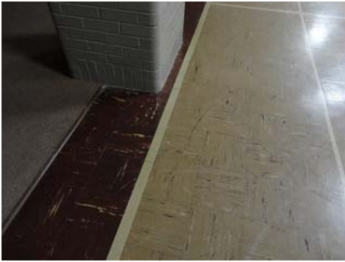
VAT in Gymnasium
