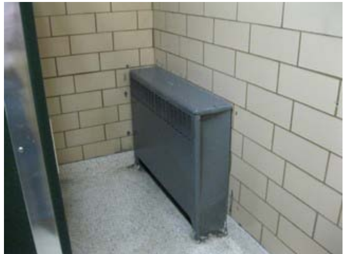
Fin Tube/Cabinet Heater
